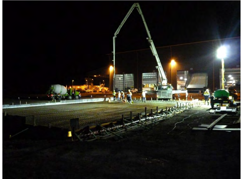
Concrete pour - temporary lube bay
